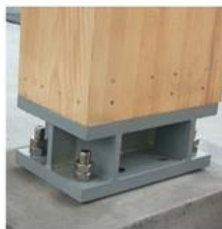
Abbildung 22: Geschraubte Verbindung Stütze - Fundament
