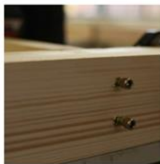
Abbildung 21: Geschraubte Verbindung Fassadenelement
